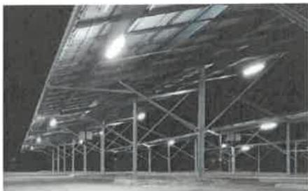
Des luminaires sont installés sous les ombrières dans le but d'améliorer la visibilité et la sécurité des usagers. Cet éclairage sera câblé sur la boucle d'éclairage existante.
