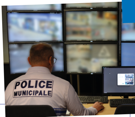
■ Le Centre de Supervision Urbaine
