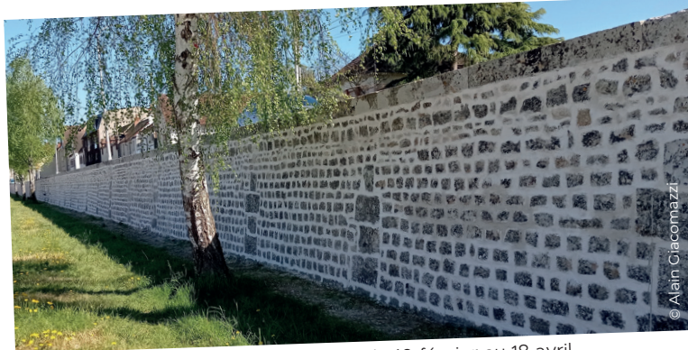
■ Le chantier était planifié du 10 février au 18 avril.
