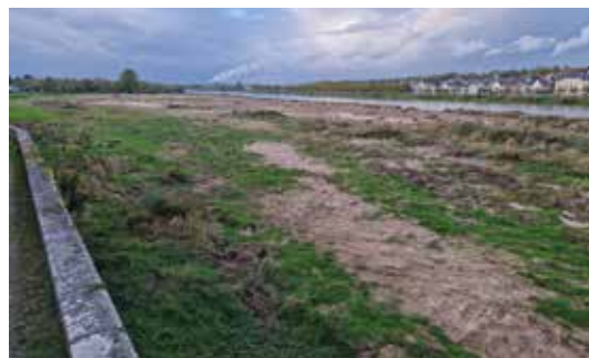
■ 31 octobre : la plage en Berry débarrassée des arbres et buissons.
