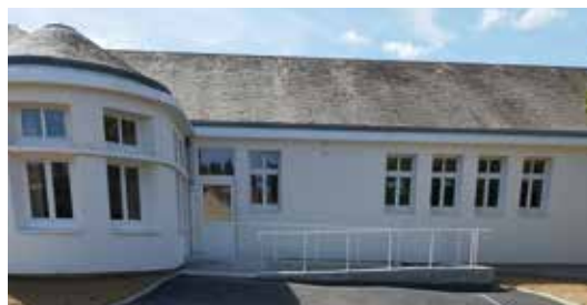
■ 7 juillet : la partie bâtementaire des travaux est achevée à l'école de la Gare.
