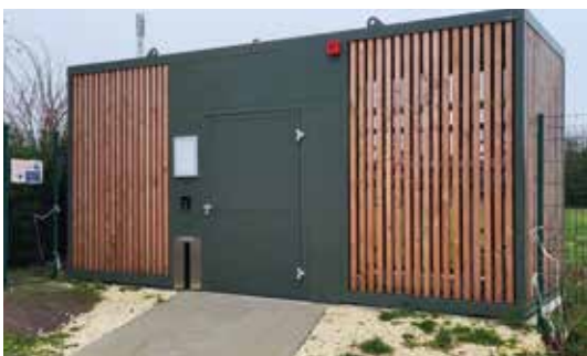
■ La Région Centre Val-de-Loire a installé une consigne à vélos à la gare.
